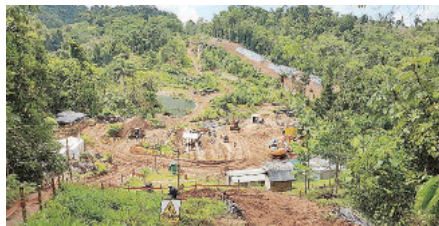
PERÙ Un'immagine del cantiere avviato da Sicim.
