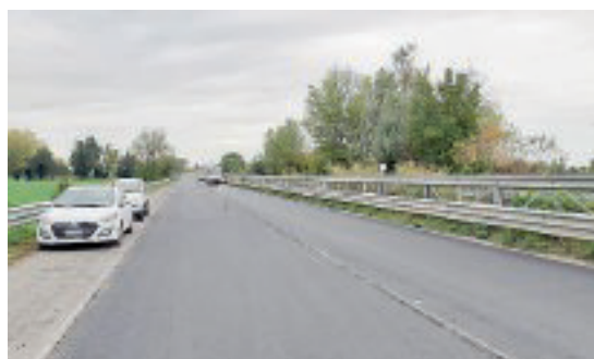
NUOVO ASFALTO Cantieri da oggi fino al 31 ottobre.
