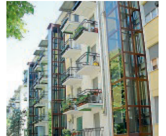
ASCENSORI Impianti esterni
