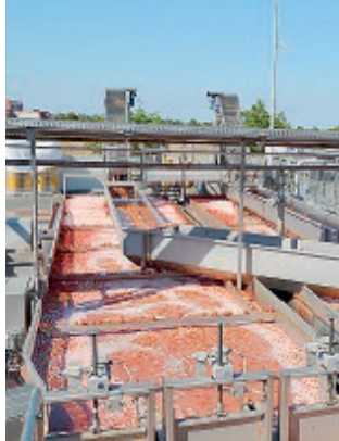
COPADOR Alcuni impianti.
