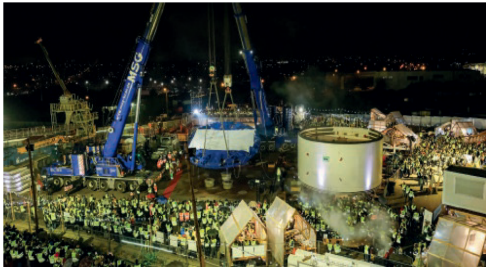
PARIGI Il nuovo cantiere della Pizzarotti alla linea 15 della metropolitana.
